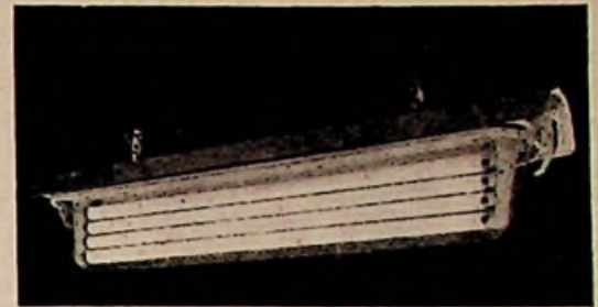
Een UB-armatuur voor 4 „TL“-buislampen 40 W.
